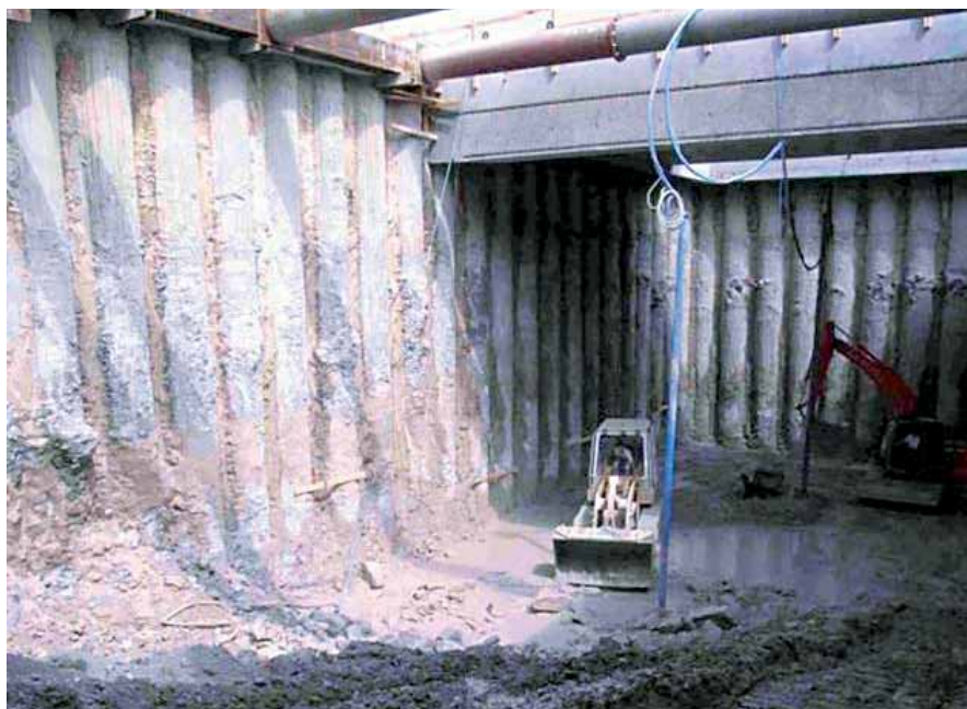
Figur 4.8 Udgravning af stationsboks mellem afstivende vægge udført med skaltpæle i armeret beton, Københavns Metro.
