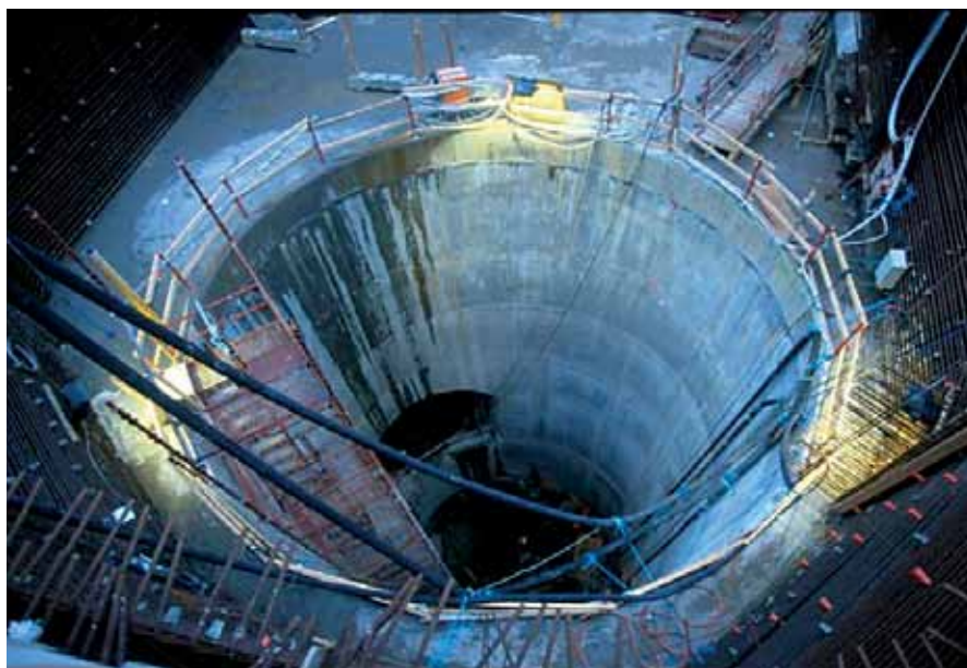
Figur 4.10 Skakt foret med beton på indersiden for opnåelse af jævn og tæt overflade, Københavns Metro.
